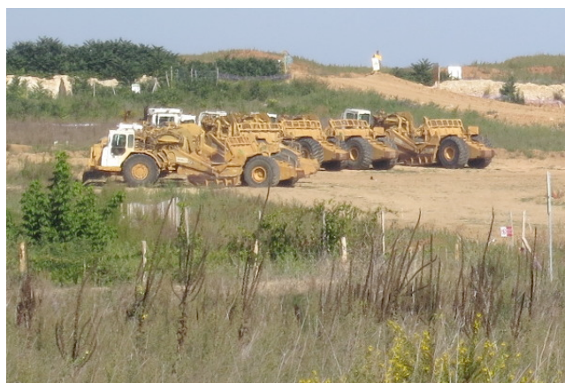
Les meilleures terres agricoles sacrifiées au béton (site de la Mogère)
