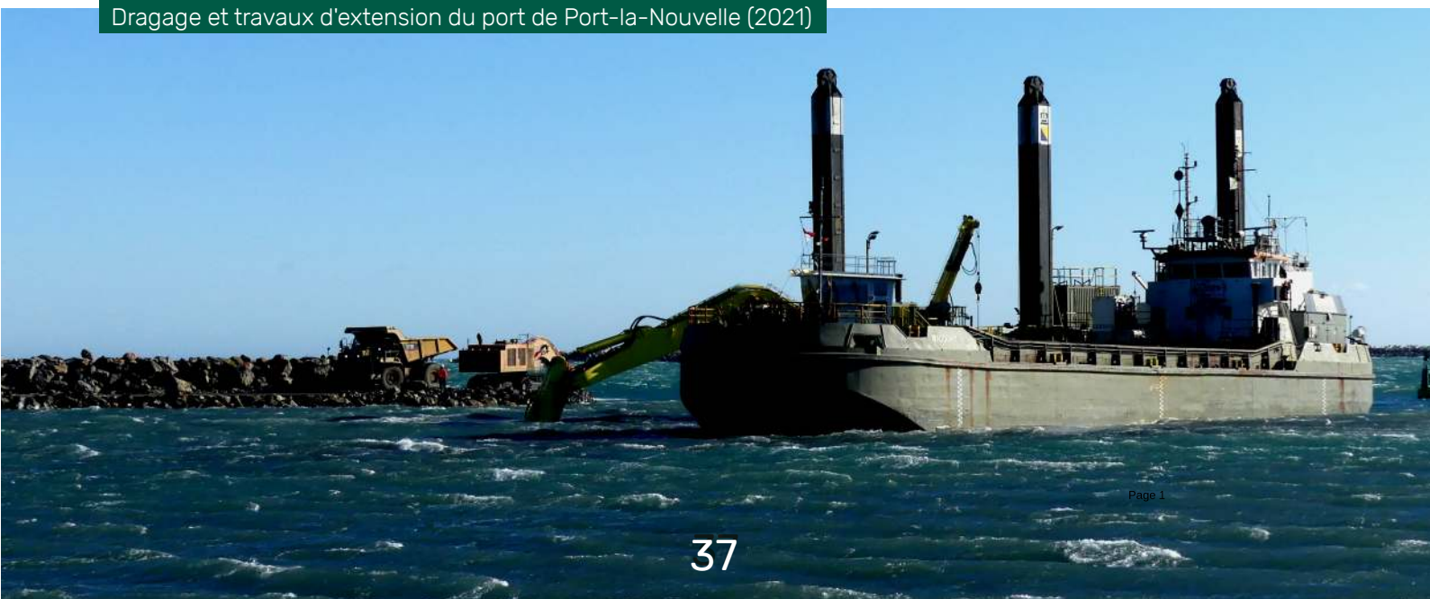
Dragage et travaux d'extension du port de Port-la-Nouvelle (2021)
